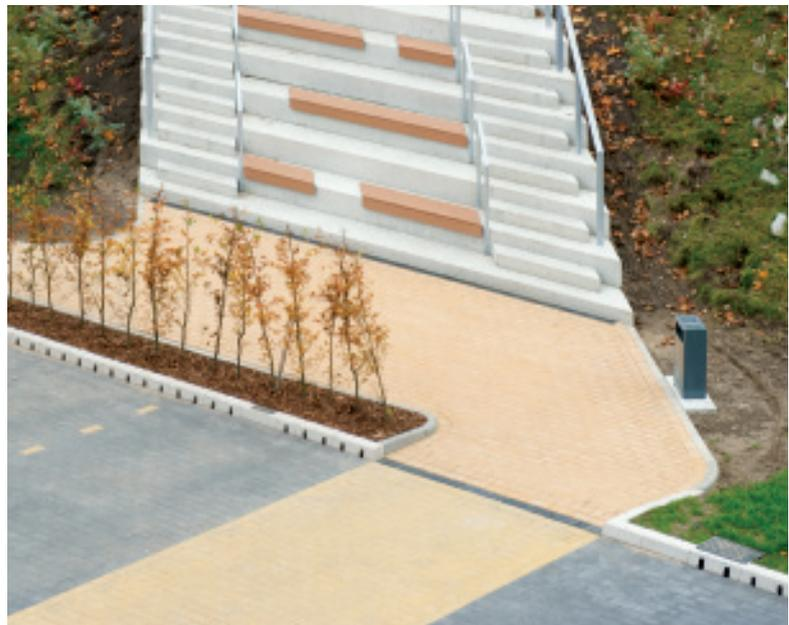
Ein Strang mit Einlaufkasten schützt die Kanalisation vor Verschlammung
