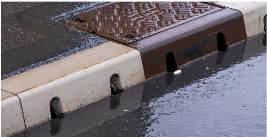
Wird der Bordstein durch eine Bordsteinrinne ersetzt, kann diese durch seitliche Einlauföffnungen Regenereignisse – von Niederschlag bis Starkregen – schnell bewältigen, indem sie das anfallende Oberflächenwasser von der Strasse abhält und es komplett aufnimmt. Pfützen verschwinden in kürzester Zeit!
