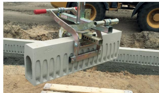
■ Zangen erleichtern das Versetzen der Elemente
