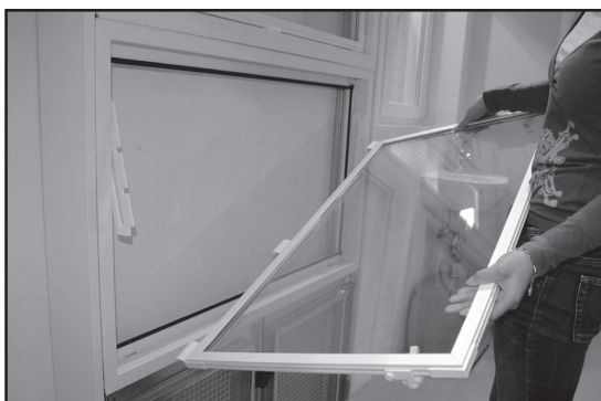
4. Der Flügel kann jetzt aus der unteren Führungsnut entnommen werden. Die Montage erfolgt in umgekehrter Reihenfolge!
