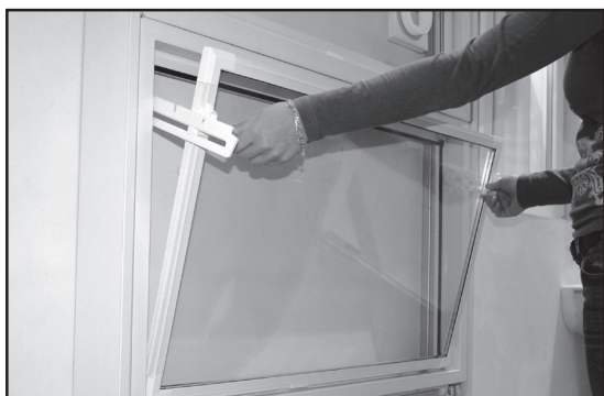
1. Durch Entriegeln der Knebel das Fenster auf Kipp stellen.
