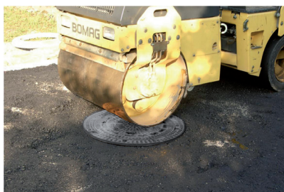
Schachtabdeckung oberflächenbündig einwalzen
