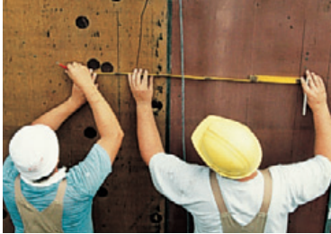
1. Leibungsfenster/Stützkreuz einmessen.
