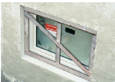
5. Die Stützkreuze verbleiben bis zum Abschluss der Rohbauphase zum Schutz vor Beschädigungen im Leibungsfenster.
