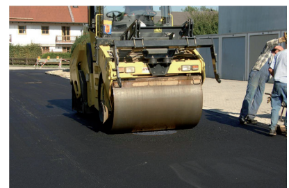
Abdeckung oberflächenbündig einwalzen
