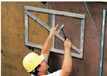
3. Stützkreuz auf der Schalung befestigen.
