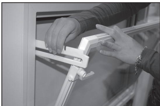
3. Die Scheren sind jetzt beidseitig aus dem Führungsstift zu entnehmen.
