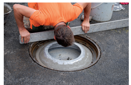
Rahmen untergiessen, 3 mm tiefer als Deckbelag hinunterklopfen
