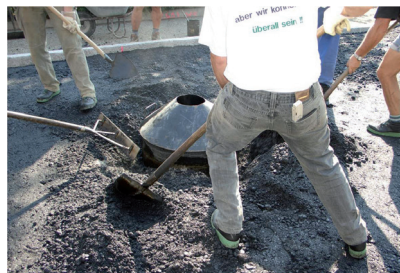
Einbauschalung in den Adapterring versetzen, Aussparung mit Bitumenmischgut verfüllen und gut verdichten
