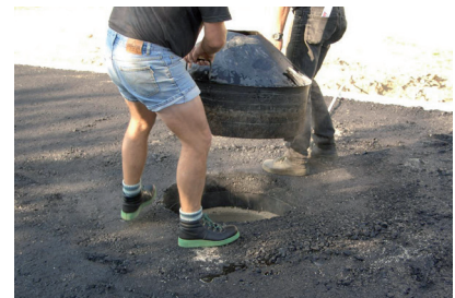
Einbauschalung vorsichtig nach oben ziehen
