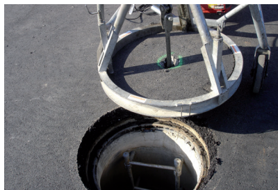
Abdeckung durchstanzen und entfernen
