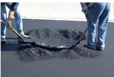
Abdeckung freilegen und hochziehen
