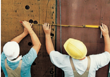
1. Leibungsfenster/Stützkreuz einmessen.
