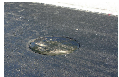
Rahmen von Tragschicht lösen, Abdeckung mit Stahlplatte abdecken, Deckbelag einbringen
