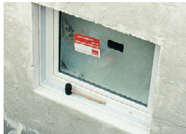
2. Das Dämmungsanschlussprofil ist leicht auf die vor Ort benötigten Dämmungsstärken von 60/80/100 cm oder 110–200 mm ohne Werkzeug anpassbar.
