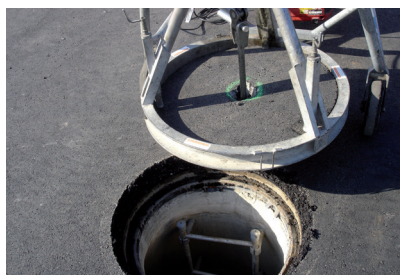
Abdeckung durchstanzen und entfernen
