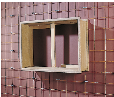
Untere Latte/Anschlagleiste zur Sicherung gegen Antrieb setzen und Leibungsrahmen durch eine vertikale Spreizung gegen Durchbiegung sichern.
