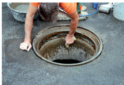
hochgezogenen Rahmen reinigen und befeuchten
