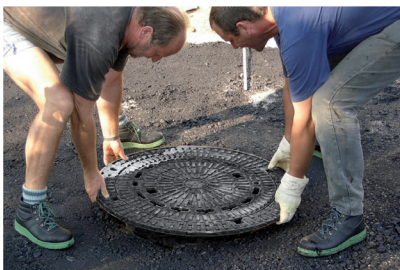
Komplette Schachtabdeckung einsetzen
