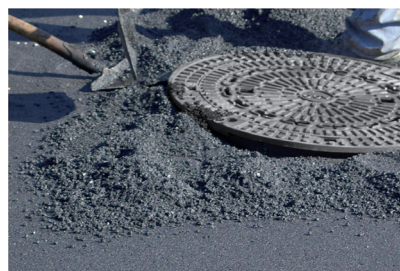
mit heissem Mischgut oberflächenbündig mit dem angrenzenden Belag unterfüttern
