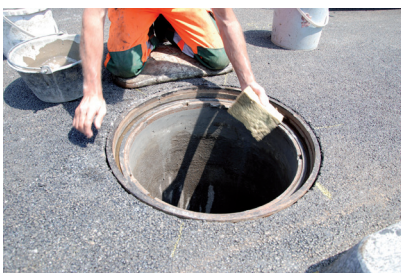
Schalung entfernen, reinigen
