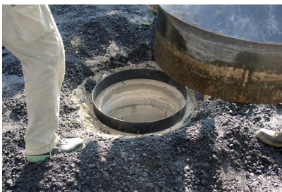
Schachtkopf freilegen, Stahlplatte entfernen, Adapterring versetzen
