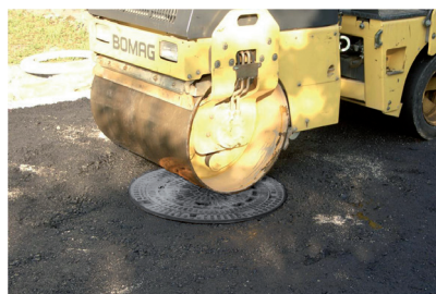
Schachtabdeckung oberflächenbündig einwalzen
