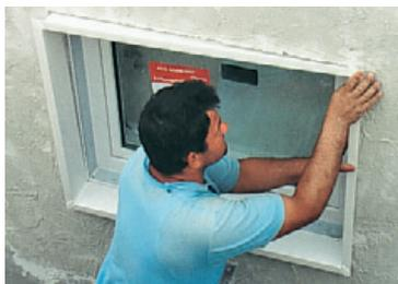
3. Une fois les travaux de revêtement mural terminés, le profilé de raccord isolant assemblé dans la rainure libérée à la suite du retrait du joint d'étanchéité du coffrage.
