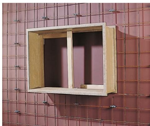
Placer la latte inférieure / le battement pour protéger de la contre-pression et sécuriser le cadre de l'ouverture d'homme à l'aide d'un latte vertical pour qu'il ne fléchisse pas.
