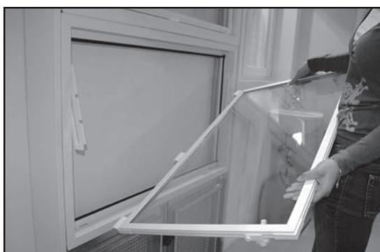
4. On peut maintenant extraire le vantail de la rainure de guidage inférieure. Le montage a lieu dans l'ordre inverse.
