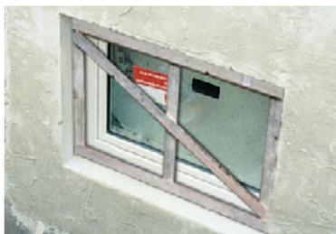
5. Les croisillons restent dans le cadre-fenêtre jusqu'à la fin de la phase de bétonnage pour le protéger des déformations.
