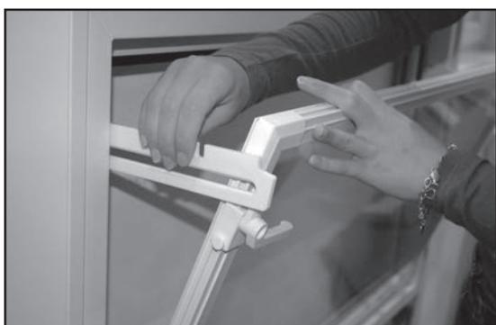
3. Dégager le système de cisaillement du doigt de guidage sur les deux côtés.
