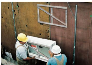
4. Mettre le cadre-fenêtre ACO Therm® sur le croisillon fini et l'immobiliser à l'aide des barres perforées latérales.
