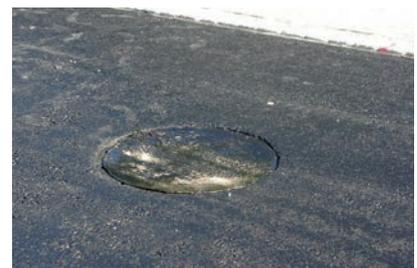
Dégager le cadre de la couche de liaison, recouvrir le puits avec une plaque de tôle, apporter la couche de revêtement
