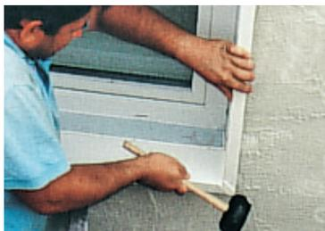
4. Le fixer dans la rainure à l'aide, p. ex., d'une mousse de montage. Procéder à l'étanchéification entre le profilé de raccord isolant et la façade à l'aide de produits courants.
