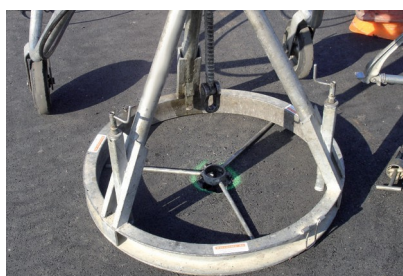
Dégager le trou de pioche, centrer l'appareil de levage
