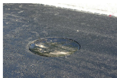
Détacher le cadre de la couche de base, recouvrir le couvercle avec la plaque en acier, poser le revêtement
