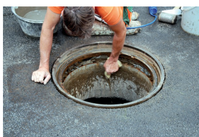
Nettoyer et humidifier le cadre relevé
