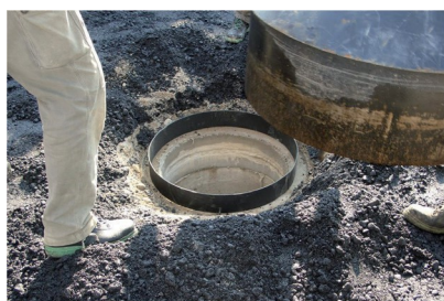
Dégager la tête du regard, retirer la plaque en acier, déplacer la bague d'adaptation
