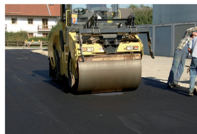
Compacter le recouvrement à fleur de la surface
