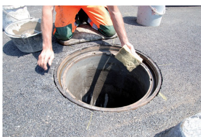
Retirer le coffrage, nettoyer supérieur
