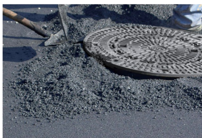
Remplir avec un enrobé chaud jusqu'à ce avec le revêtement adjacent
