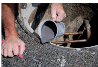
Joint entre le cadre et le revêtement
