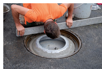
Arroser le cadre, enfoncer à 3 mm plus bas que le revêtement supérieur
