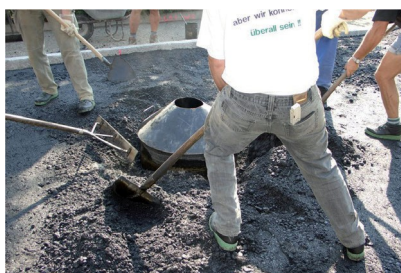
Placer le coffrage dans la bague d'adaptation, remplir l'évidement avec un enrobé bitumineux et bien compacter
