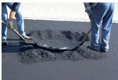
Dégager le couvercle et le soulever qu'il affleure la surface.
