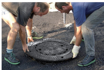
Mettre en place le couvercle de regard complet
