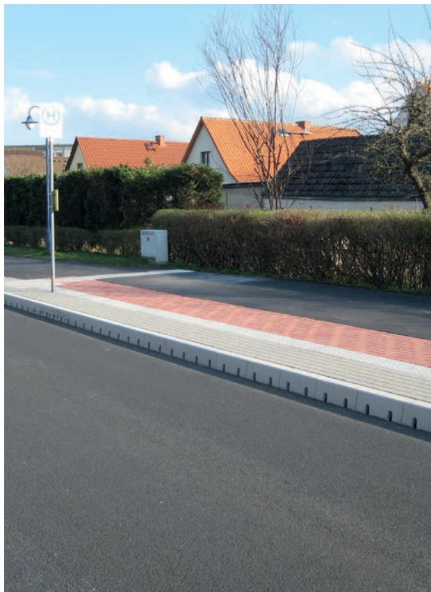
Accès au bus sans obstacle grâce à la bordure surélevée de 18 cm
