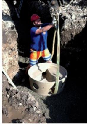
2. Versetzen Schachtboden auf horizontale Betonsohle
