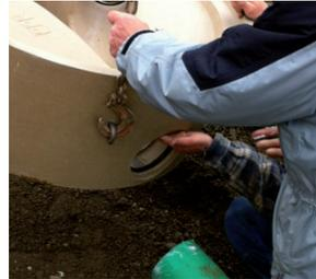
8. Aufbringen vom geeigneten Gleitmittel auf den Dichtungsring
