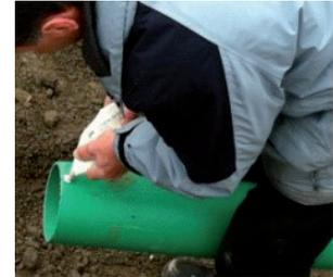
9. Aufbringen von geeignetem Gleitmittel auf dem Anschlussrohr
