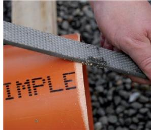
7. Anschleifen des Kunststoffrohres
