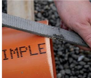
7. Anschleifen des Kunststoffrohres
