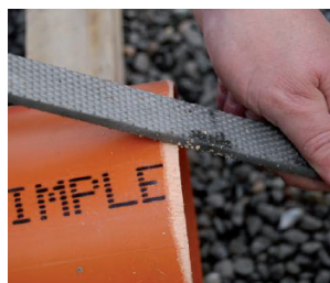
7. Ponçage du tuyau en plastique
