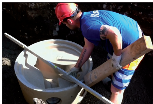
3. Contrôle de la position du fond de la chambre
