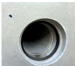
6. Détail du manchon de raccordement de tuyau
