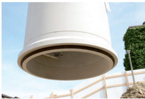
2. Contrôle du joint d'étanchéité
