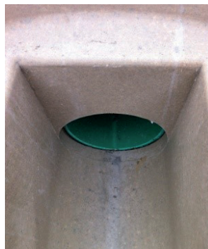
11. Fente optimale de manchon après insertion et alignement du tuyau en plastique
