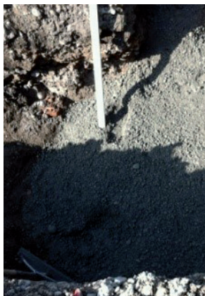
1. Préparation de la semelle de fouille
