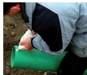
9. Appliquer du lubrifiant approprié sur le tuyau de raccordement.
