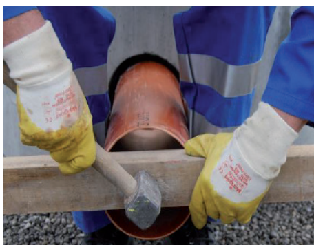
10. Centrage du tuyau en plastique. Étancher le tuyau en plastique avec un coup puissant selon les intempéries (température).
