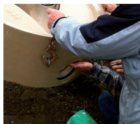
8. Appliquer du lubrifiant approprié sur la bague d'étanchéité
