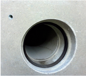
6. Dettaglio del manicotto per il collegamento dei tubi
