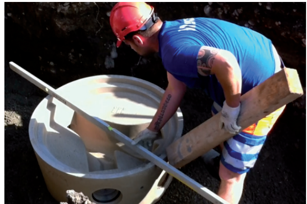
3. Controllo della posizione del fondo per pozzetto
