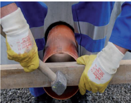
10. Posizionamento centrato del tubo di plastica. Sigillatura del tubo di plastica con un forte colpo, a seconda delle condizioni atmosferiche (temperatura).
