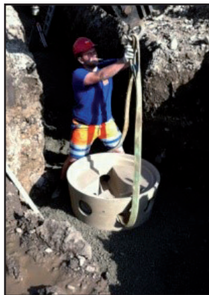
2. Posa del fondo per pozzetto
