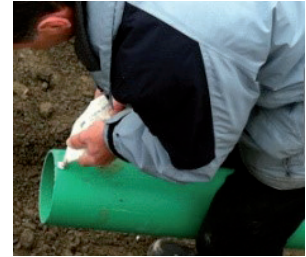
9. Applicazione di lubrificante idoneo al tubo di collegamento
