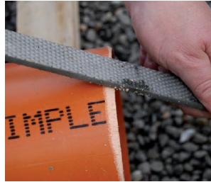
7. Smussatura del tubo di plastica
