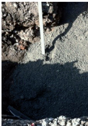
1. Preparazione del fondo dello scavo
