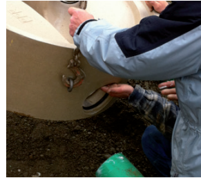
8. Applicazione di lubrificante idoneo all'anello di tenuta
