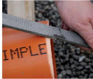
7. Smussatura del tubo di plastica
