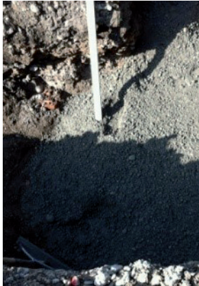
1. Preparazione del fondo dello scavo
