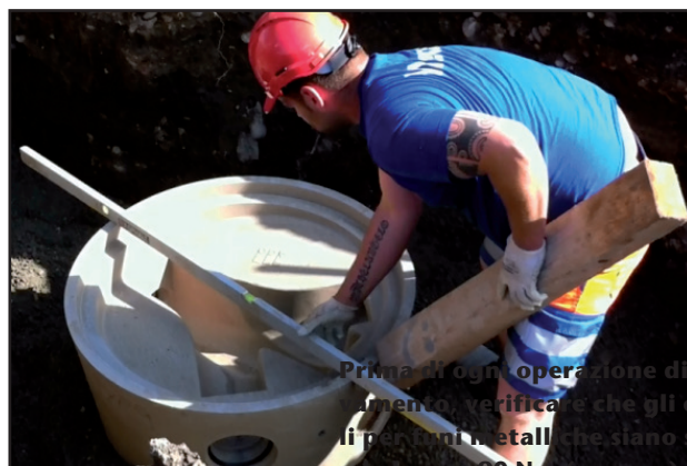
3. Controllo della posizione del fondo per pozzetto
