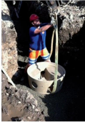
2. Posa del fondo per pozzetto su un sottofondo in calcestruzzo orizzontale
