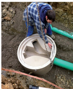
1. Posa del fondo per pozzetton
