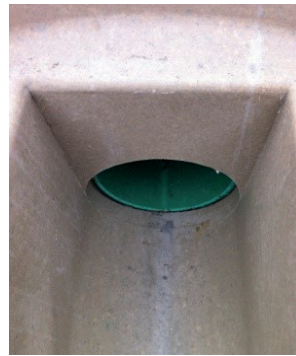
11. Interspazio ottimale del manicotto dopo l'inserimento e il raddrizzamento del tubo di plastica
