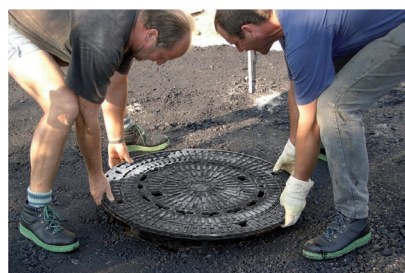
Mettere il chiusino per pozzetto completo
