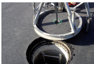
Tagliare il mento stradale e rimuovere il coperchio
