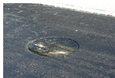
Allentare il telaio dallo strato legante (binder), ricoprire con lamiera, applicare lo strato di copertura
