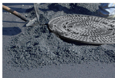
Uniformare il rivestimento adiacente a filo della superficie mediante l'applicazione di miscela bituminosa a caldo
