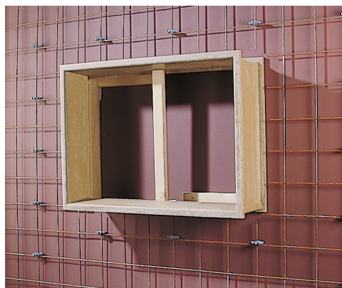
Mettere il listello/la barra degli scontri inferiori come sicurezza contro la sottopressione e assicurare il telaio dell'intradosso tramite una traversa contro l'inflessione.
