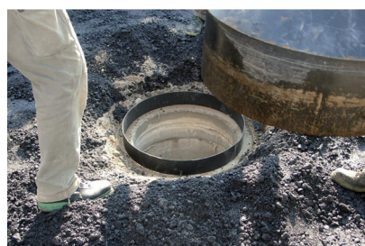
Mettere il chiusino per pozzetto allo scoperto, togliere la lamiera di acciaio, collocare l'anello guida
