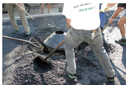
Assestare la cassaforma nell'anello adattatore, riempire la cavità con mescola 6 bituminosa e compattare bene
