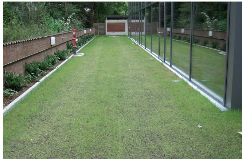
Grüne Flächen können für Pflegefahrzeuge mit der ACO Rasenwabe wasserdurchlässig und befahrbar befestigt werden
