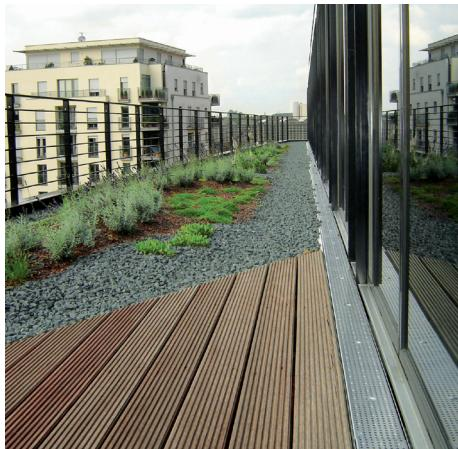
È possibile ottenere diverse varianti di design grazie alle diverse versioni di griglie. La regolazione variabile dell'altezza consente un adattamento millimetrico alle condizioni del terreno locale. In questo modo ACO non solo soddisfa i requisiti futuri dell'edilizia senza barriere architettoniche, ma anche le esigenze di qualità di
