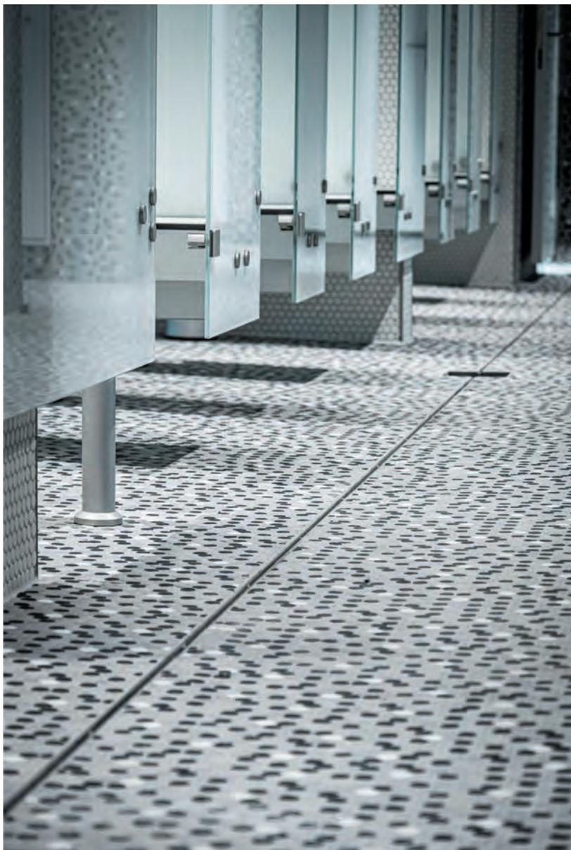
I canaletti a fessura scaricano le acque reflue sporche e di lavaggio dalle superfici del pavimento nella condotta di drenaggio senza pericolo per le persone e senza danni agli edifici. La variante di canaletto ottimale da scegliere per il drenaggio dipende principalmente dal sito di installazione.
