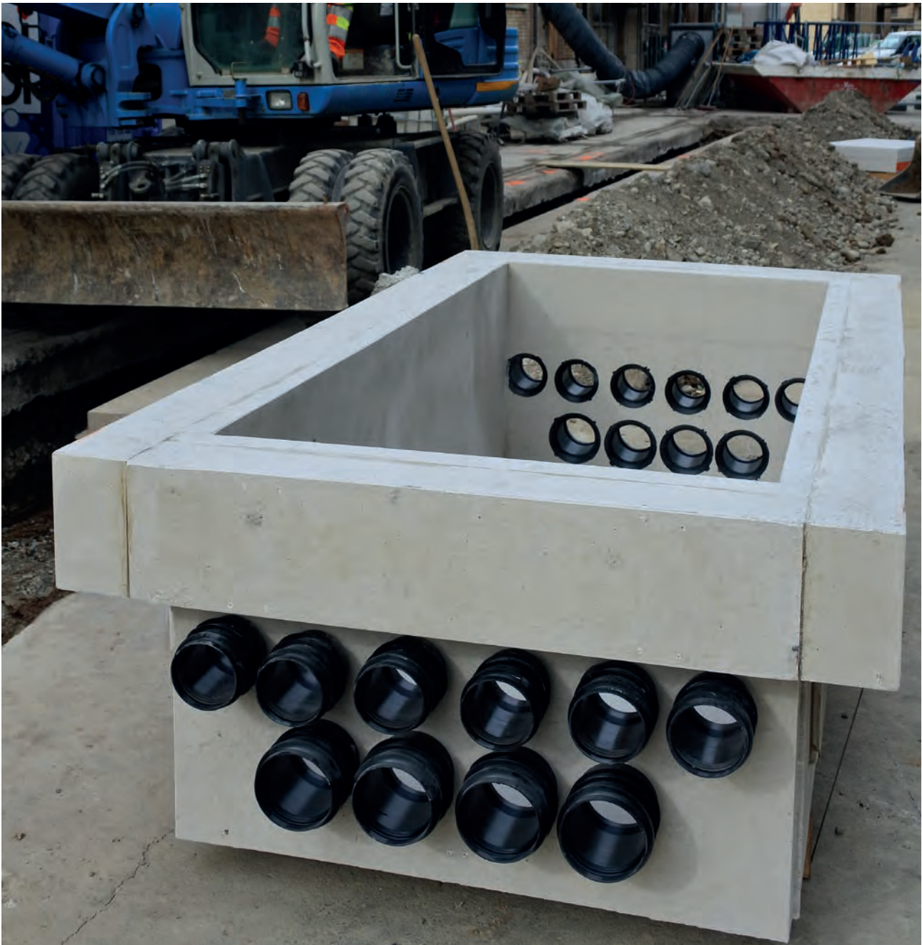
In einem Industrieareal erfolgt die Erneuerung der Kabelkanalisation. ACO Standardschächte mit individueller Gestaltung der Kabeleinführungen ermöglichen eine schnelle Abwicklung.
