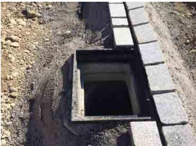
Angefangen vom Aufsetzen des Betonsockels auf den Schacht oder Schlamm-sammler bis zu den Steinarbeiten vereinfacht der Betonsockel Typ 7 "Spresa" die Arbeitsschritte und spart Zeit und Kosten.
