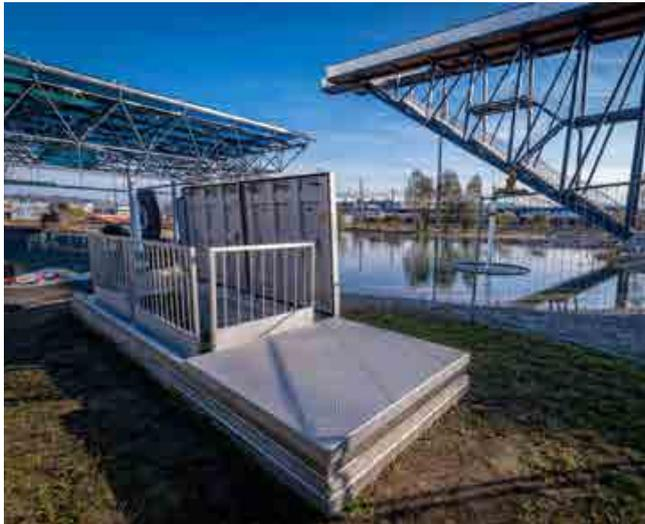
Sonderschachtabdeckungen kommen immer dann zum Einsatz, wenn herkömmliche Abdeckungen den projektspezifischen Anforderungen nicht mehr gerecht werden. ACO Detego Schachtabdeckungen sind speziell für diesen Bereich und bieten für jeden Anspruch eine individuell passende Lösung: ein- oder mehrteilig, mit Öffnungshilfe, mit automatischer Öffnung oder ganz ohne Öffnungshilfe, als Notausstieg oder Bodentor, in allen gewünschten Formen.
