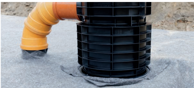
Das Geotextil wird eingeschnitten und am Schacht angepasst
