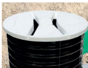
L'ausilio per casseforme/la copertura protettiva deve proteggere l'apertura durante tutta la fase di posa
