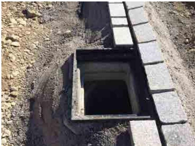
De la pose du socle en béton sur le regard ou les collecteurs de boues aux ouvrages en pierre, le socle en béton de type 7 «Spresa» simplifie les phases de travail et permet d'économiser du temps et de l'argent.
