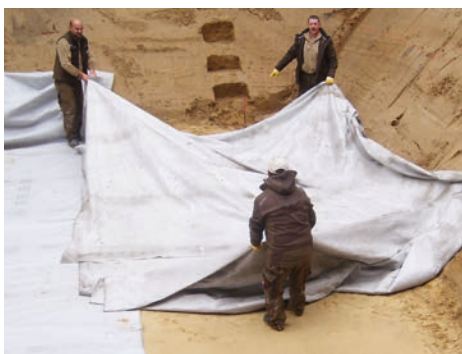
Après la réalisation d'une plate-forme plane, exempte de pierres et de pentes, la fouille est recouverte d'un non-tissé filtrant.
