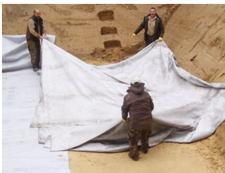
Dopo aver creato un sottofondo livellato, privo di pietre e pendenze, la fossa di scavo viene rivestita con un vello filtrante.
