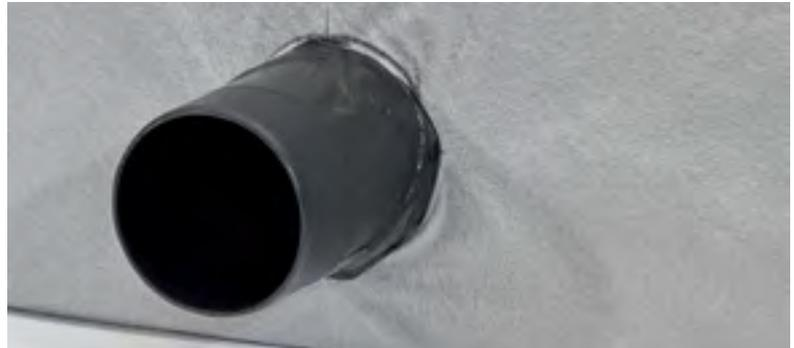
Il geotessile viene tagliato e spinto sopra l'adattatore del tubo.
