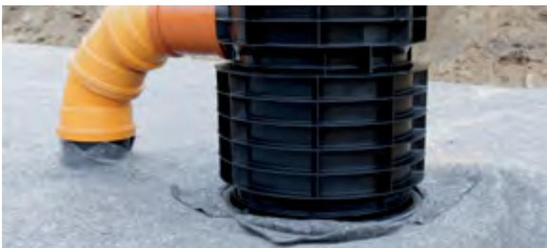
Il geotessile viene tagliato e montato sul pozzo.
