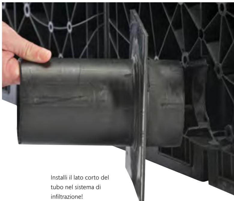
Installi il lato corto del tubo nel sistema di infiltrazione!
