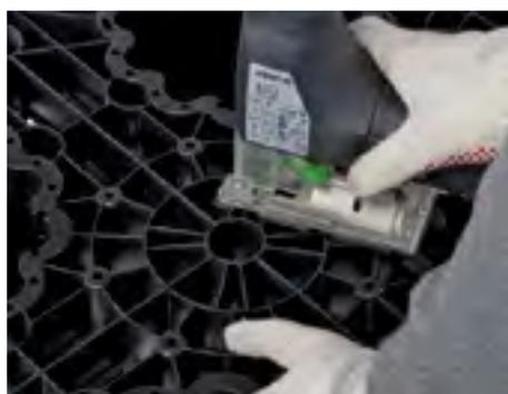
Per ritagliare le aperture per le penetrazioni dei tubi sulle pareti laterali e sulla parte superiore degli elementi di base, è necessario un seghetto alternativo con una lama extra-lunga.
