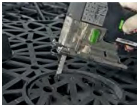
Per segare l'apertura di collegamento del tubo sulla parete laterale è necessario un seghetto alternativo con una lama extra lunga.
