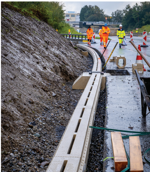
Le monobloc ACO S en action, pour un drainage optimal des routes
