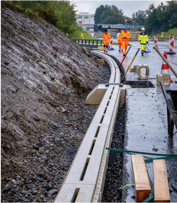
Il monoblocco ACO S in azione, per un drenaggio stradale ottimale
