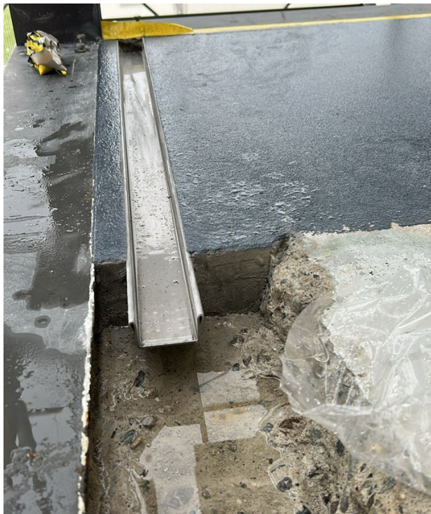
Phase de test des caniveaux de balcon
