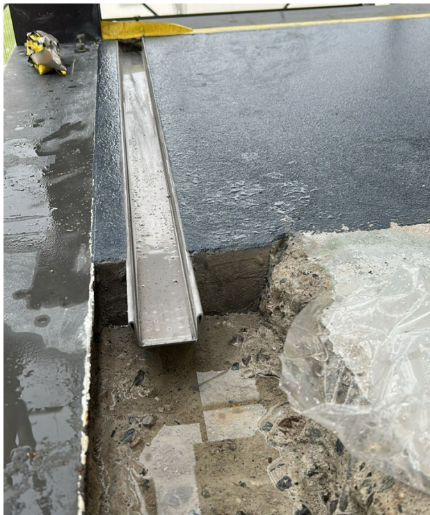
Fase di prova delle canalette per balconi
