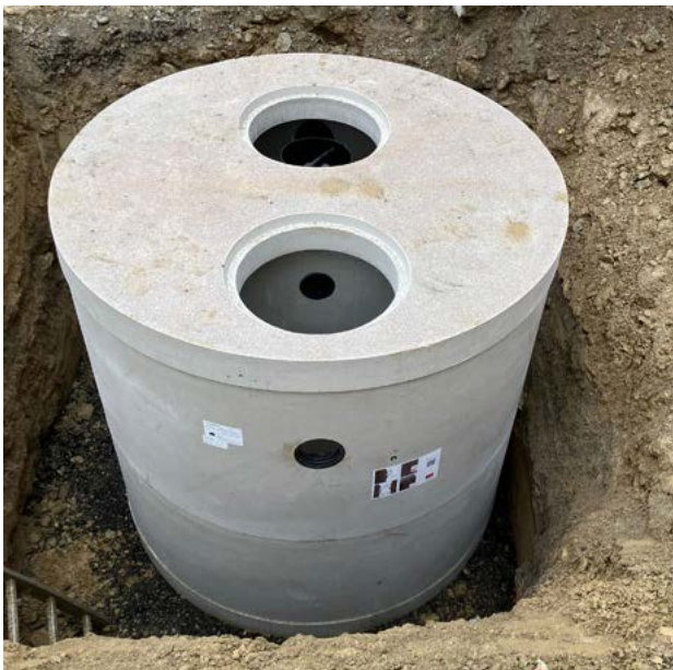
Einbau der Kompaktanlage
