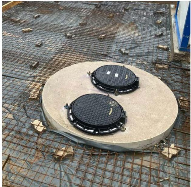
Installation compacte ACO avec couvercles en fonte moulée étiquetés équipée de couvercles en fonte estampillés afin que les différents systèmes soient clairement identifiés. Cette solution garantit non seulement une séparation fiable des liquides légers dans un espace réduit, mais répond également à toutes les exigences en matière de sécurité, de signalisation et de facilité d'entretien.
