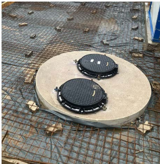
Impianto compatto ACO con coperchi in ghisa con iscrizione
