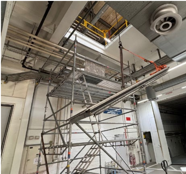
Aufbau für die Montage von der Unterseite
