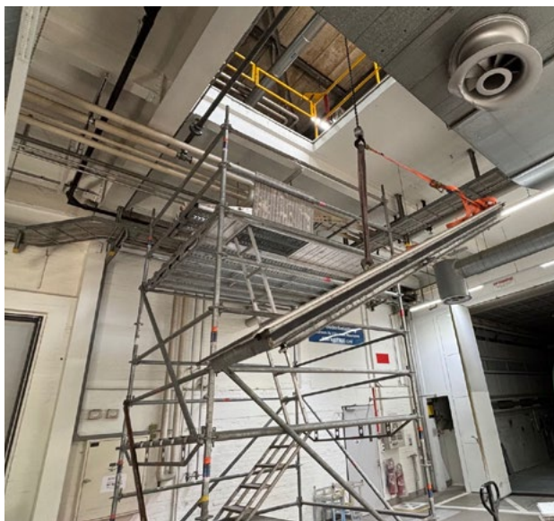
Structure pour le montage par le dessous
