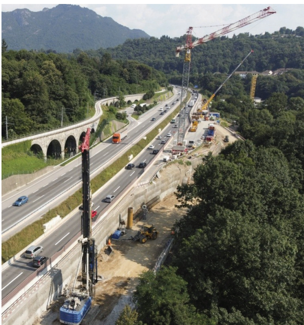
Travaux sur la N2 entre Gentilino et Lamone dans le cadre du projet de maintenance EP28
