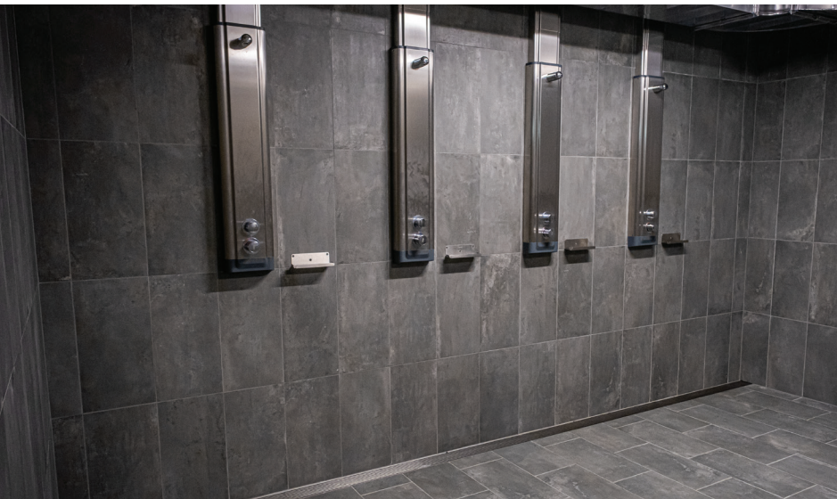
Le caniveau ACO Wellness garantit un drainage sûr dans la zone de douche.
