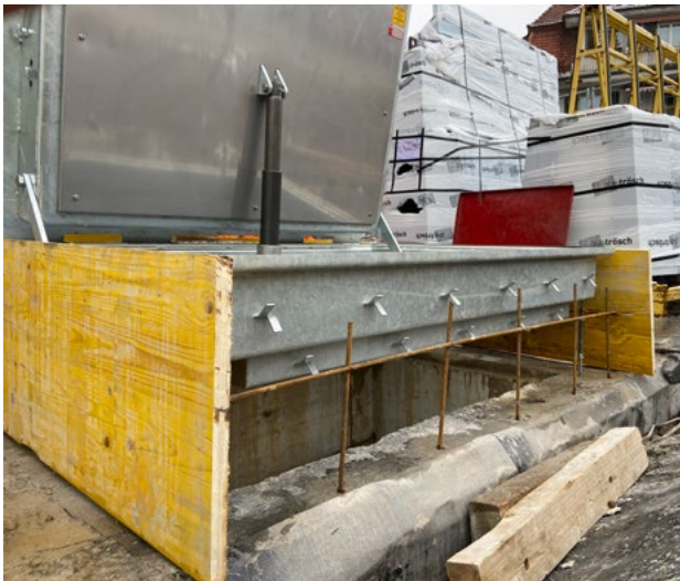
Einbau ACO Entrauchungsklappe an der Poststrasse Süd
