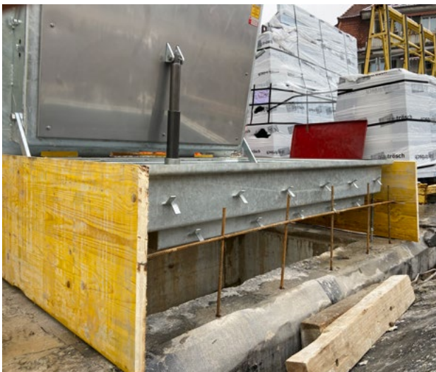
Installation d'un clapet de désenfumage ACO dans la Poststrasse Süd
