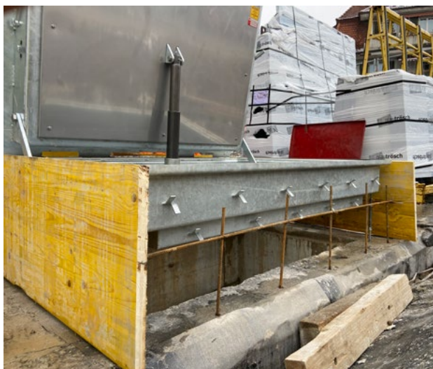
Installazione di una serranda di evacuazione fumi ACO
