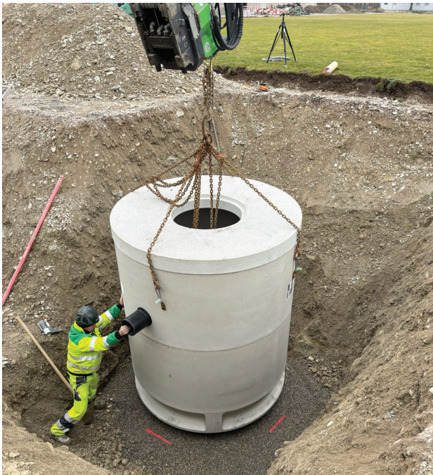
Der ACO Stormclean wird eingebaut
