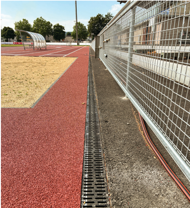
Die ACO Multiline V100G wird eingebaut
