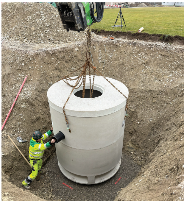
L'ACO Stormclean viene installato
