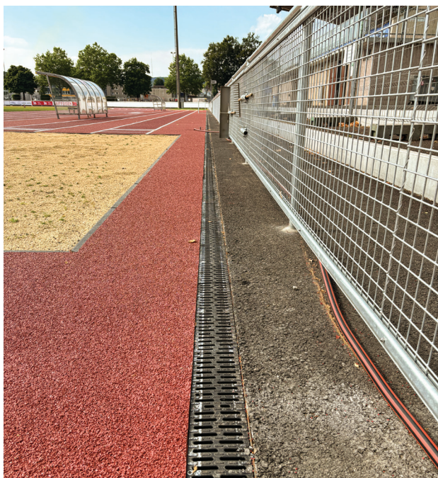
L'ACO Multiline V100G viene installato
