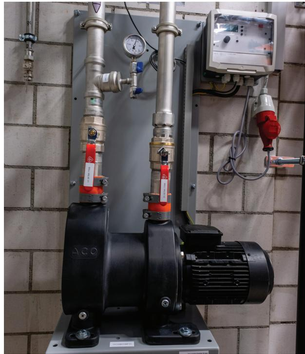
wie im Technikraum. Durch die hohe Strömungsgeschwindigkeit während des Absaugvorgangs werden Ablagerungen verhindert. Dies reduziert nicht nur den Wartungsaufwand, sondern erhöht zugleich die Betriebssicherheit des Systems.
