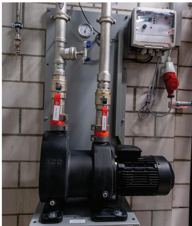
L'elevata velocità del flusso durante il processo di aspirazione impedisce la formazione di depositi. Ciò non solo riduce la manutenzione, ma aumenta anche la sicurezza operativa del sistema.
