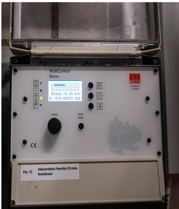
Il sistema di controllo ACO MultiControl visualizza in modo chiaro gli stati di funzionamento.
