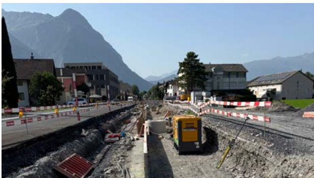
Einbau des Filterschachtes
