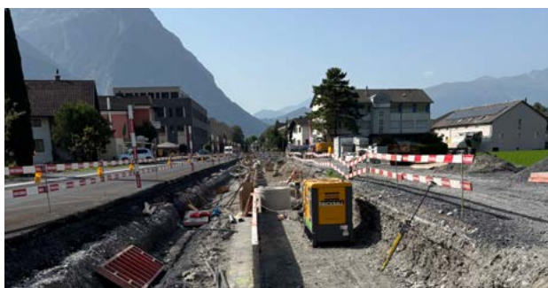
Installation du puits filtrant
