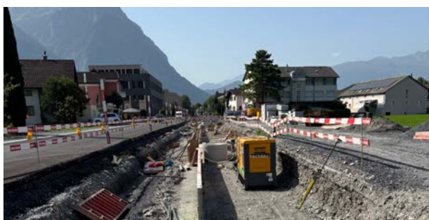
Installazione del pozzetto filtrante
