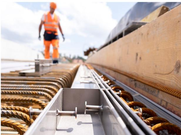
Der Doppelschlitzaufsatz in Edelstahl V4A als Sonderanfertigung mit Edelstahlbolzen, die ein Ablösen vom Beton verhindern
