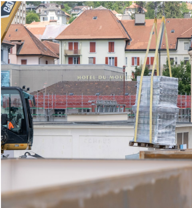
Les caniveaux ACO NEXITE® sont livrés et installés
