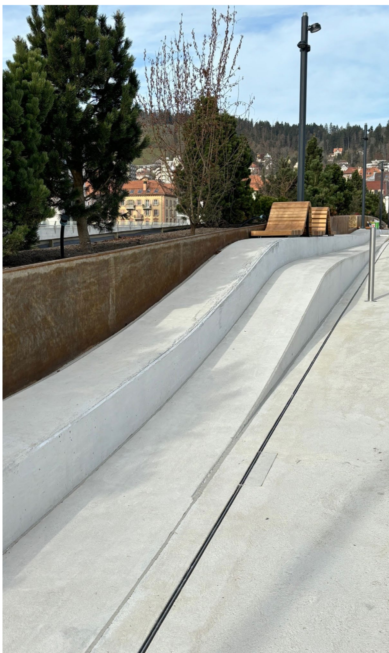
Le nouveau Grand-Pont à La Chaux-de-Fonds avec les produits ACO installés
