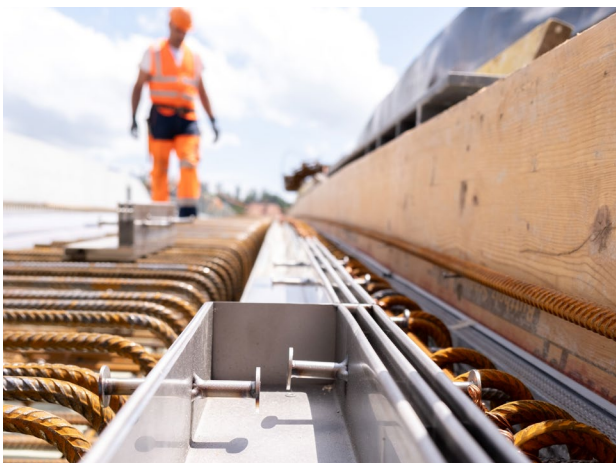
La double fente en acier inoxydable V4A est une fabrication spéciale avec des boulons en acier inoxydable qui empêchent le détachement du béton
