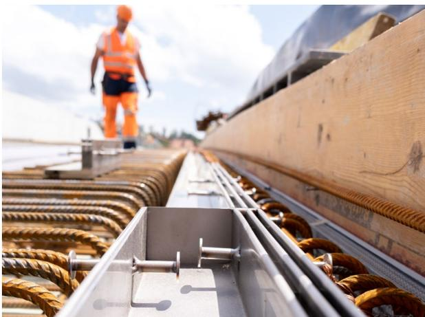
Il doppio caditoia a fessura in acciaio inox V4A è una realizzazione speciale con bulloni in acciaio inox che impediscono il distacco dal calcestruzzo.
