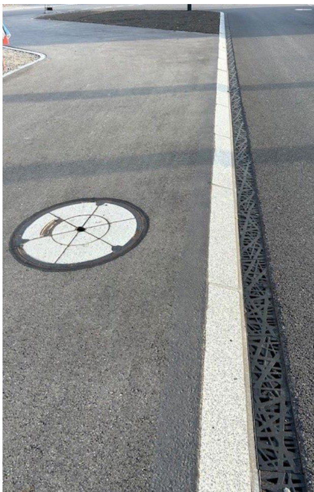
Prodotti ACO installati nella stazione ferroviaria e degli autobus di Sursee
