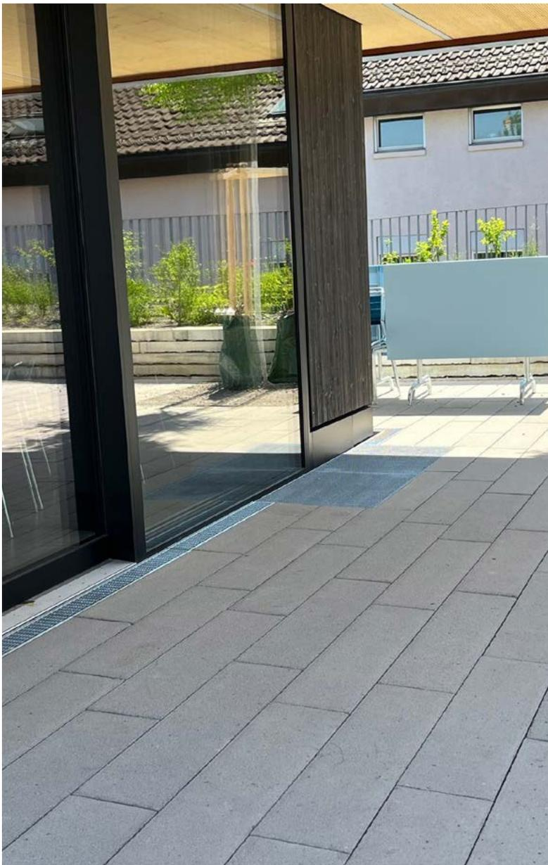
Einheitlicher Übergang zwischen der ACO DRAIN® Multiline und dem ACO Intotec Sauberlaufrost
