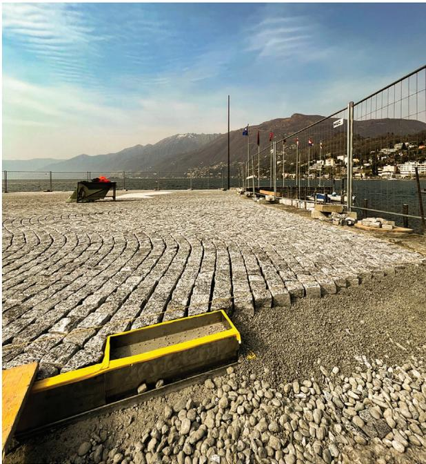
Die ACO Multiline V100 mit Doppelschlitzaufsatz wird eingebaut
