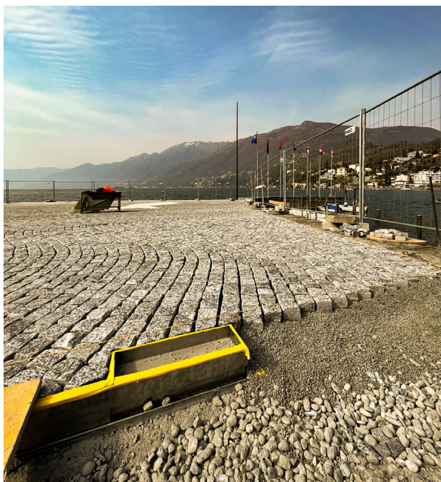
L'ACO Multiline V100 con doppio attacco a fessura viene installato
